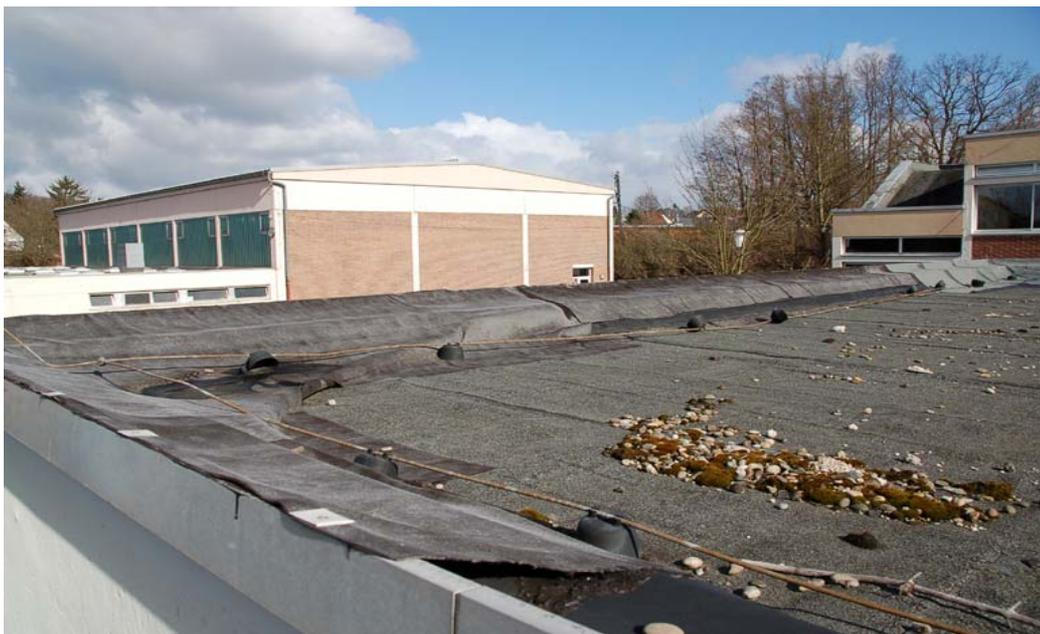
Foto 4 - mangelhafte Flachdachabdichtung (beispielhaft)
