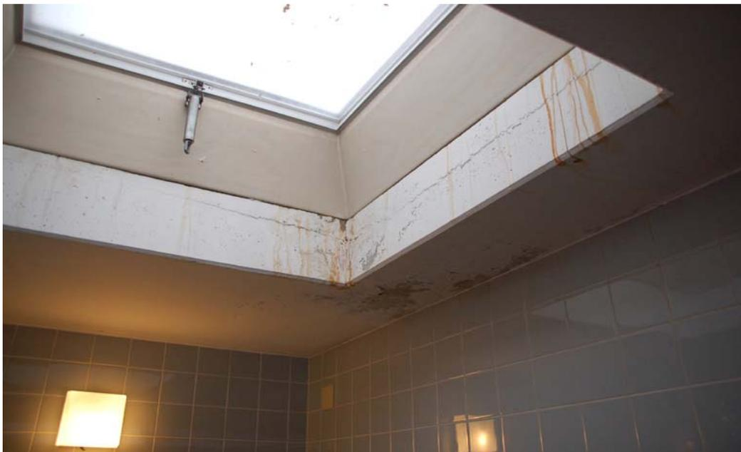
Foto 5 - Merkmale von Feuchtigkeit im Dachbereich (beispielhaft)
