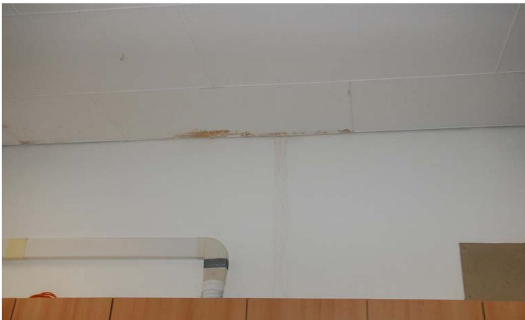
Foto 6 - Merkmale von Feuchtigkeit im Dachbereich (beispielhaft)
