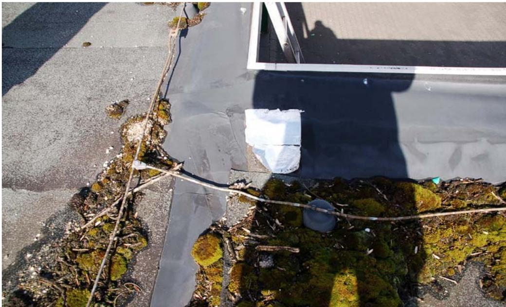
Foto 2 - mangelhafte Flachdachabdichtung (beispielhaft)
