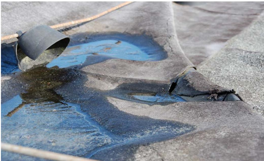
Foto 3 - mangelhafte Flachdachabdichtung (beispielhaft)
