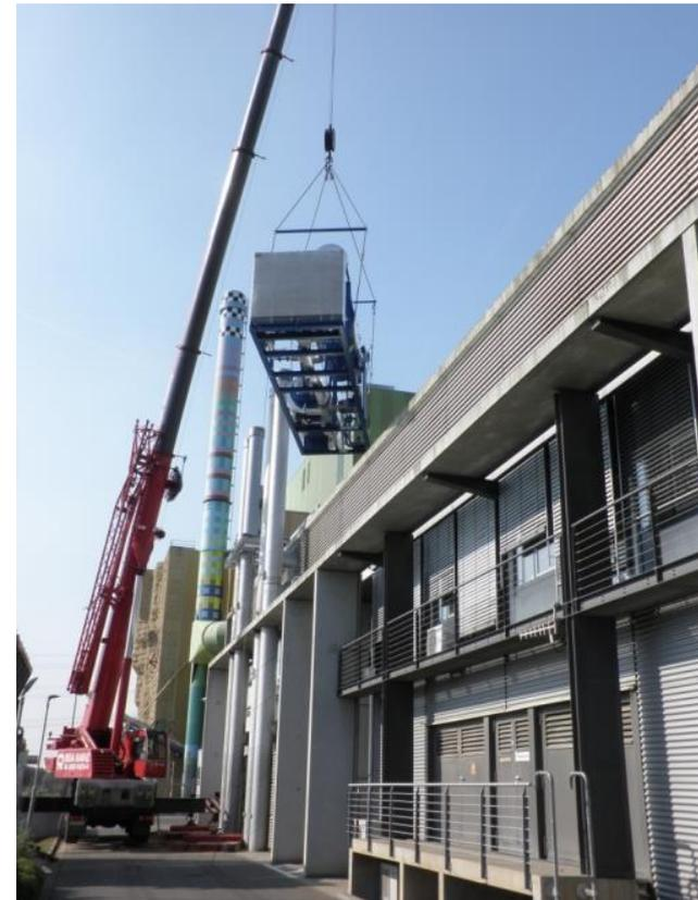
Zwei Hochtemperatur-ORC-Module zur Stromerzeugung aus Abwärme wurden am Deponiestandort in Flörsheim-Wicker eingebaut.
