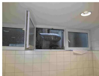
analog den Lüftungsgeräten für die Klassenräume, jedoch wird die Zuluft über ein Kanalsystem mit Gittern in die Räume eingeblasen, bzw. als Abluft über Fettfanggitter entnommen.
