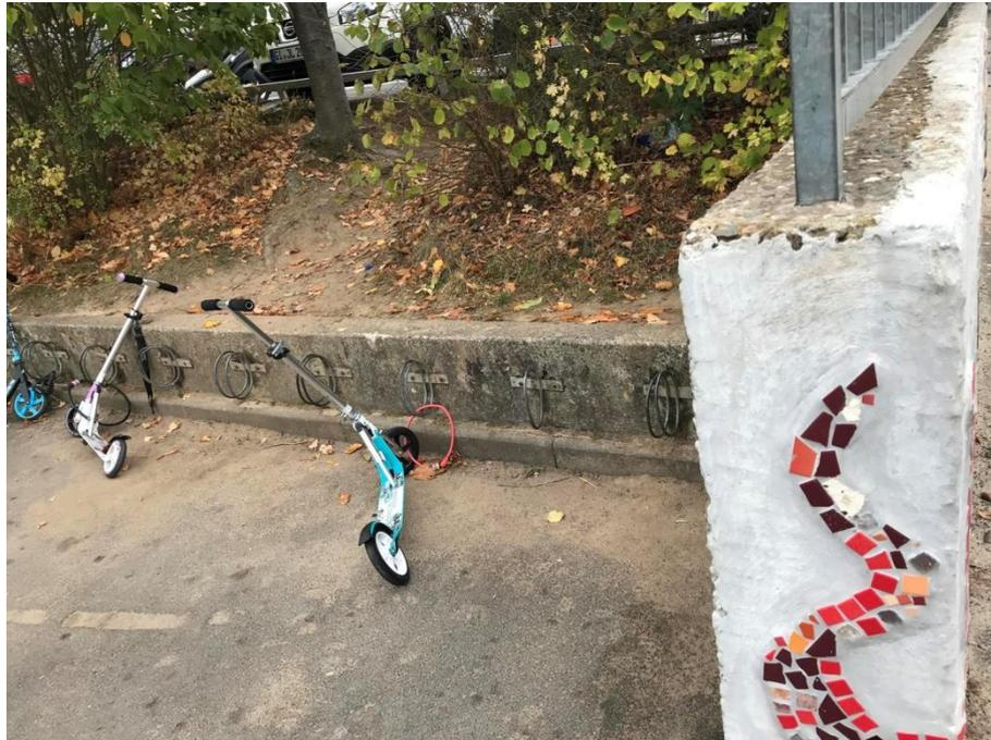
Abbildung 4-5: Beschädigte Vorderradhalter mit Wandbefestigung (Limesschule, Pohlheim)
