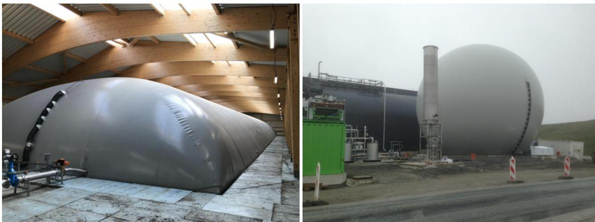
**Abbildung 33: links: Zeppelingasspeicher, rechts: Freistehender Gasspeicher (3/4-Kugel)**
