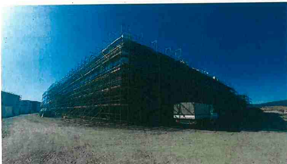
Abb.: Foto Außenansicht GAZG vom 26.04.2021
