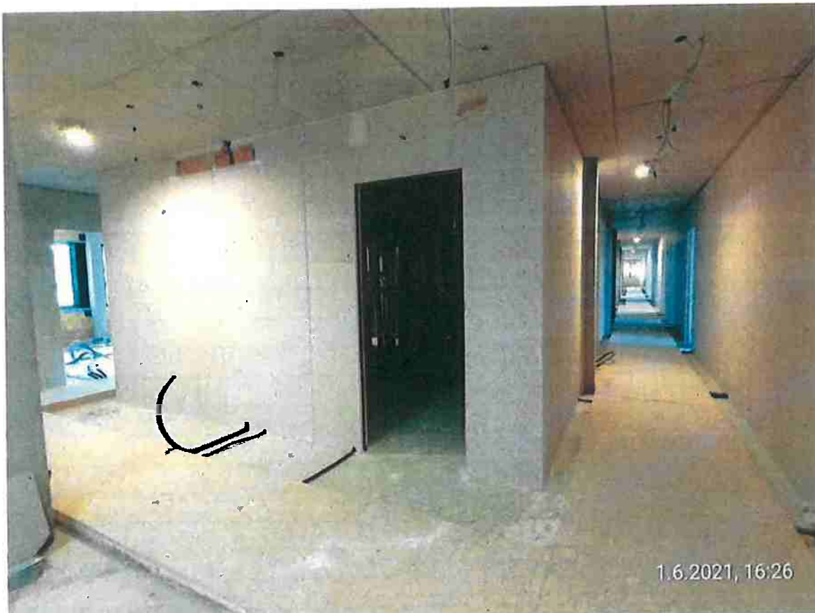
Abb.: Foto Innenausbau GAZG vom 01.06.2021
