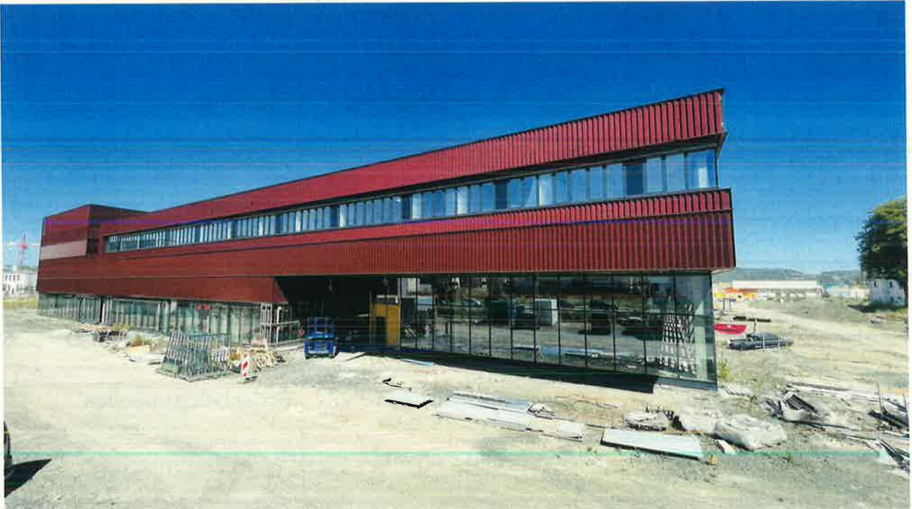
Abb.: Gebäudefront vom 16.08.2022
