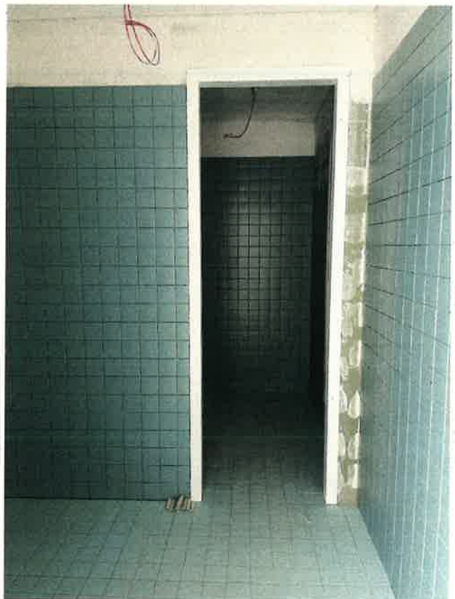
Abb.: Innenausbau vom 23.05.2022
