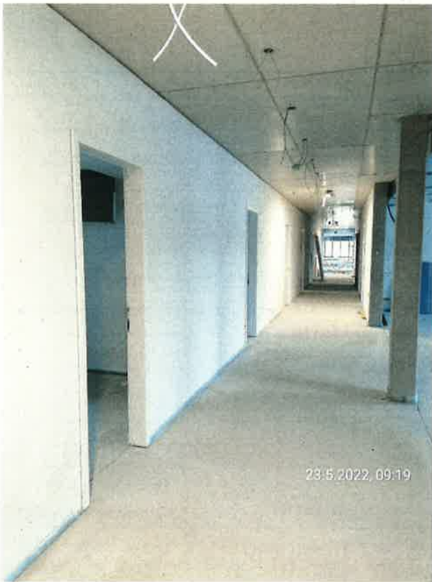
Abb.: Innenausbau vom 23.05.2022
